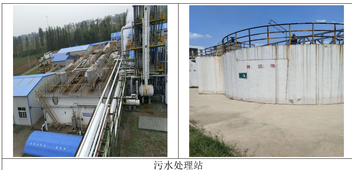
图 4-1 项目污水处理站
